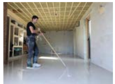
Stap 3 - Vloer afwerken
